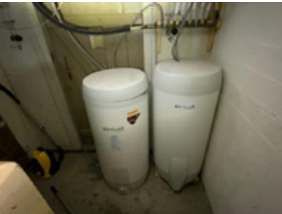
Varmtvannstanker i kjeller
