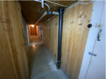
Støpejernsrør i kjeller
