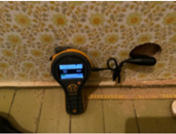
Fuktundersøkelse i vegg
