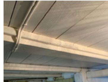
Merke etter borebiller i kjellerhimling
