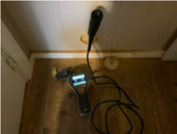
Fuktundersøkelse i vegg
