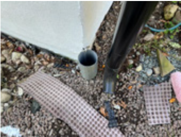
Takrennenedløp ledes vekk fra boligen
