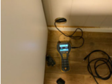
Fuktundersøkelse i vegg
