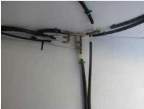
Provisorisk montering av røropplegget.
