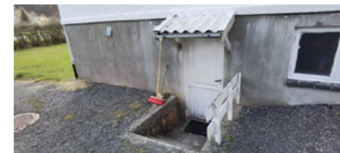
Utvendig trapp til underetasje
