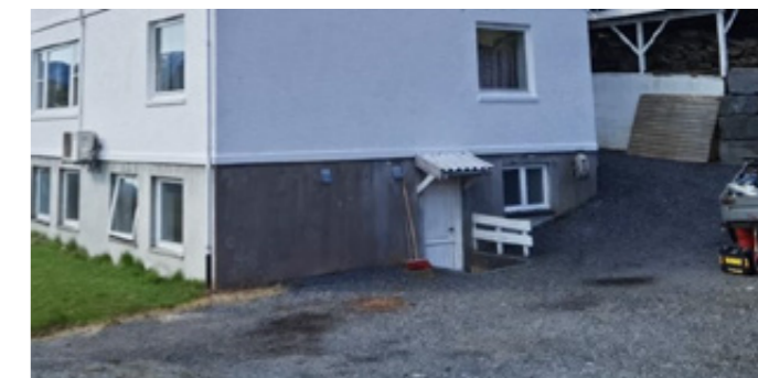
Utvendig terreng ved byggets nordside
