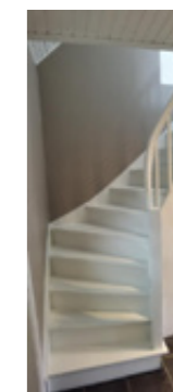
Trappeløp mellom 2.- og 3. etasje
