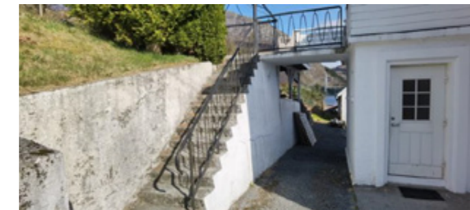
Utvendig trapp til 2. etasje
