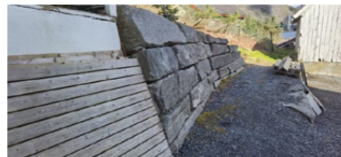
Støttemur av steinmur
