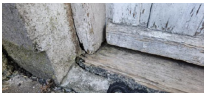
Roteskada utside ytterdør underetasje
