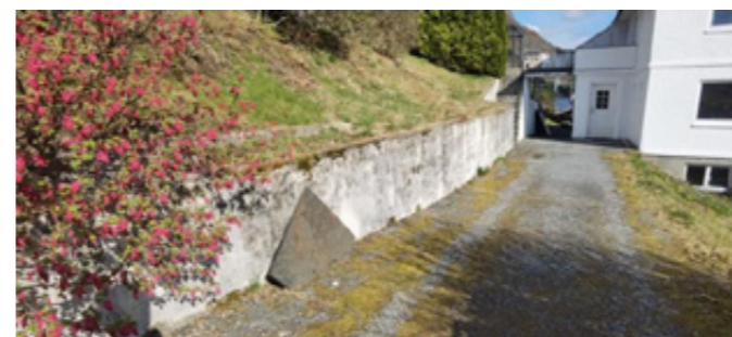
Støttemur av betong
