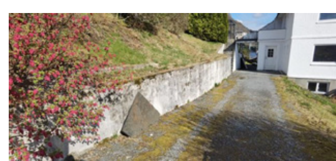
Støttemur av betong
