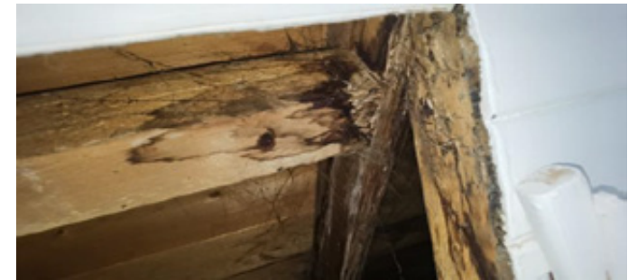
Missfarga del av innvendig tak, synleg frå kaldloft
