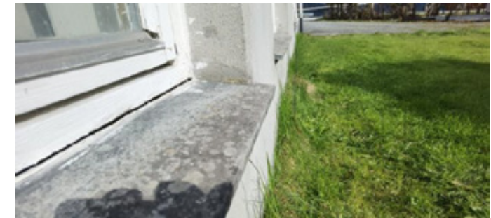
Opning mellom utvendig vassbrett av skifer og vindaug
