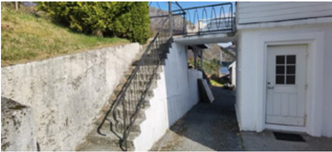
Utvendig trapp til 2. etasje
