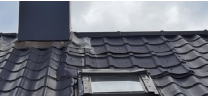
Lappa taktekking over takvindauge
