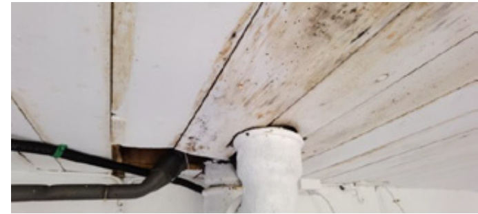
Roteskada himling/etasjeskille i kjeller
