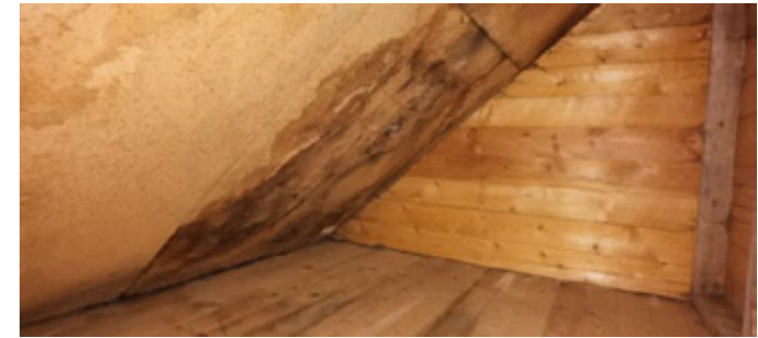
Missfarga del av innvendig tak, synleg frå kneloft
