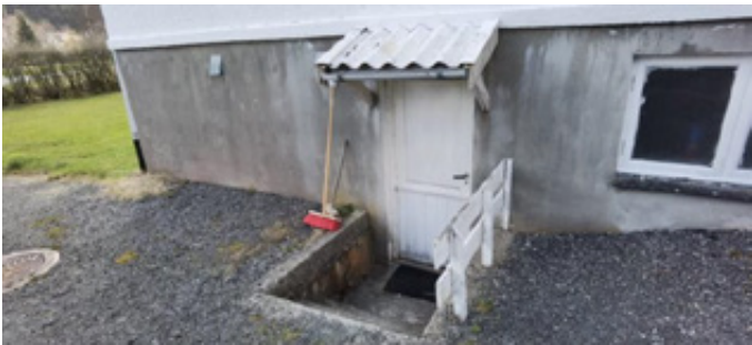
Utvendig trapp til underetasje
