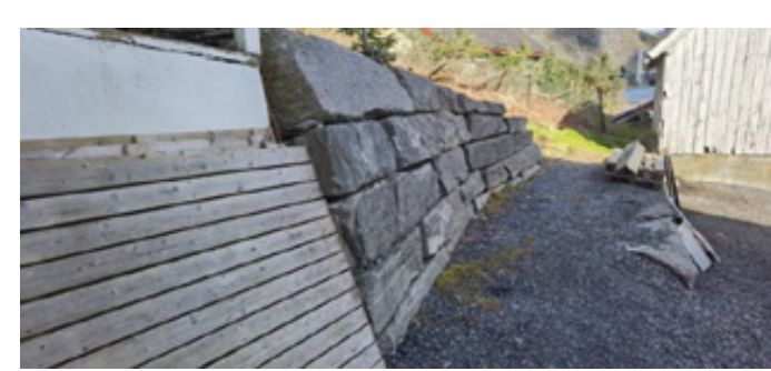
Støttemur av steinmur
