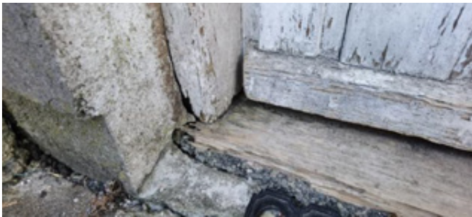
Roteskada utside ytterdør underetasje
