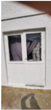
Roteskada utside ytterdør underetasje
