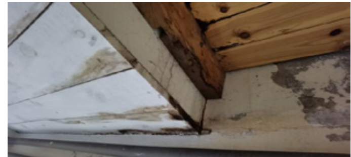
Roteskada himling/etasjeskille i kjeller
