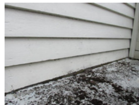
Nederste kledningsbordet langs altanen bør skiftast til metallbeslag.
