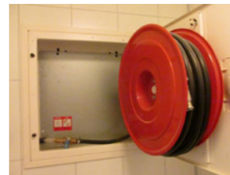
Brannslange i veggskap i toalettrommet.
