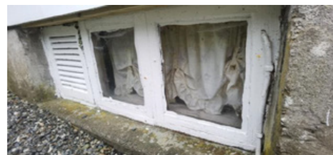
Vindaug i grunnmur, tett på utvendig terreng
