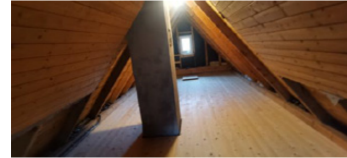
Kaldloft i opphavleg del av huset
