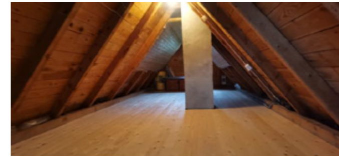
Kaldloft i opphavleg del av huset
