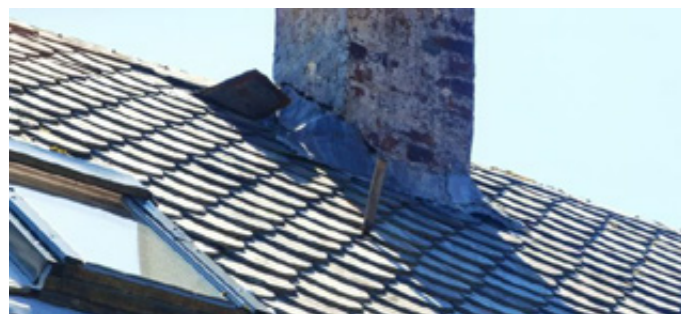
Utvendig pipebeslag
