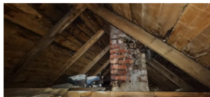
Kaldloft opphavleg bygning
