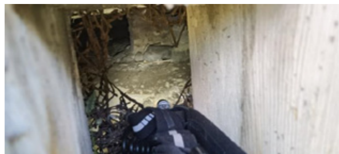
Bilete tatt inn mot krypkjeller, ved ventil i grunnmur
