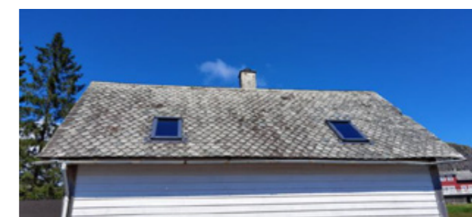
Takfall mot sør
