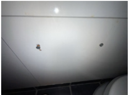
Monteringshull på baderomsplatene.
