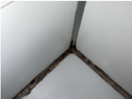
Svertesopp på silikon i dusjhjørne.
