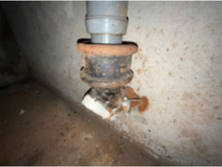
Avløpsrør av støpejern som er ført gjennom grunnmuren.
