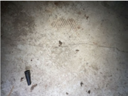
Sprekker i betonggulv.
