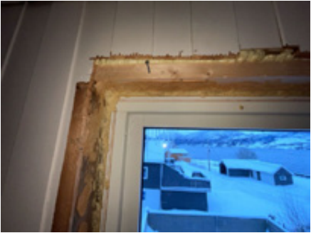
Mangler foring og listverk på balkongdør i trapperom.
