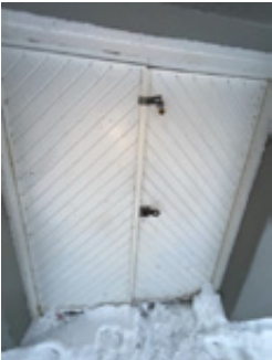
Mangler foring og listverk på balkongdør i trapperom.
