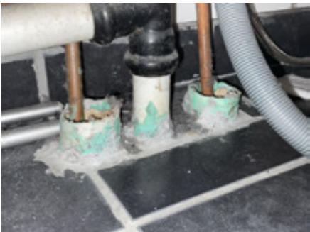
Utettheter ved rørgjennomføring i gulv.
