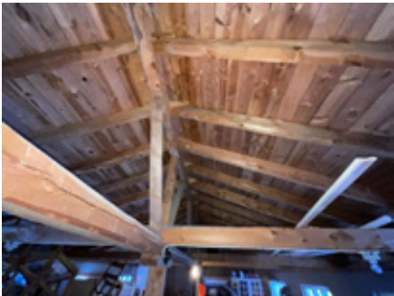
Takkonstruksjon i lager.
