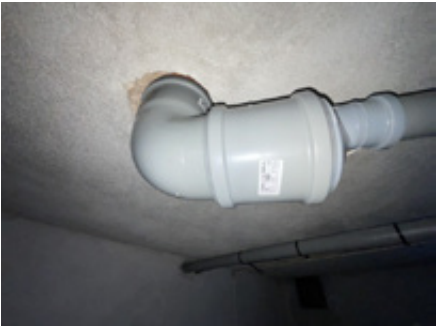
Avløpsrør fra Biltema som er synlig i kjelleren.
