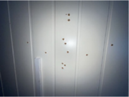
Monteringshull på veggplater.
