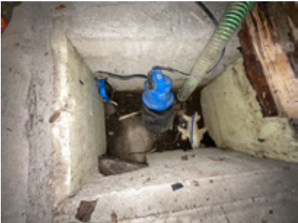
Lensepumpe i kjellergulv.
