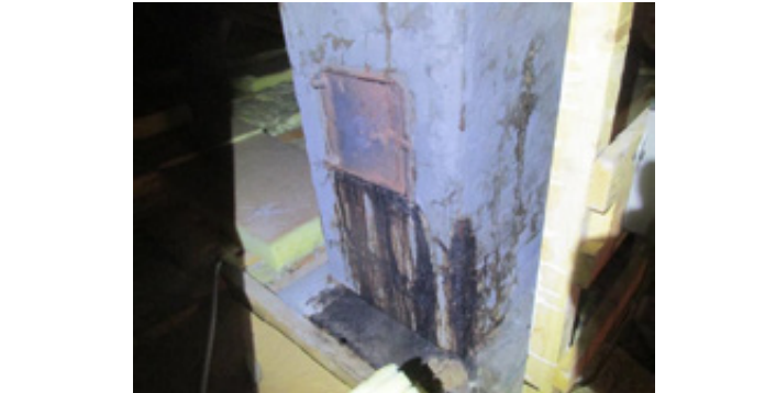
Feieluke i kaldloftet.
