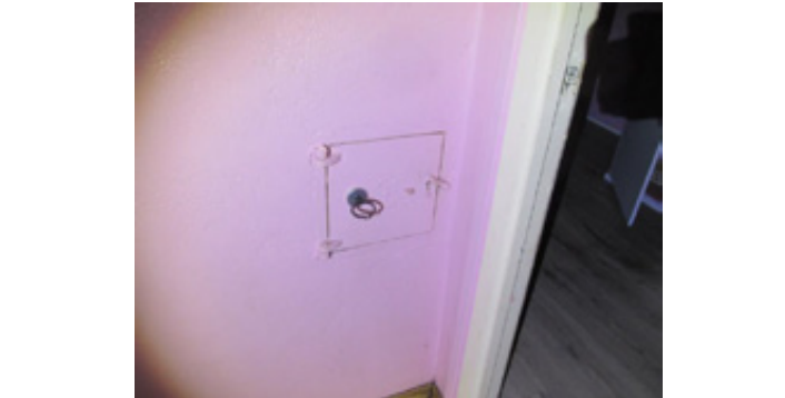
Sotluke i underetasjen.
