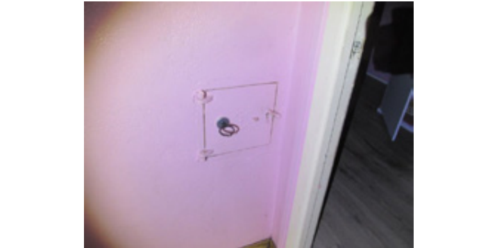
Sotluke i underetasjen.
