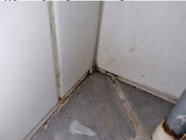
TG 2 10.1.3 Membran, tettesjiktet og sluk
