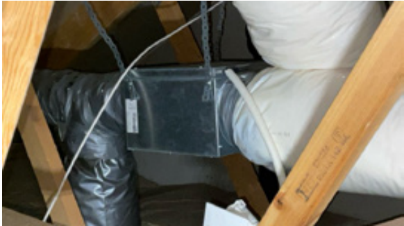
Driftsenhet for mekanisk avtrekk.
